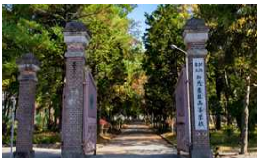
【明治37年建立の校門、赤レンガ造り】
